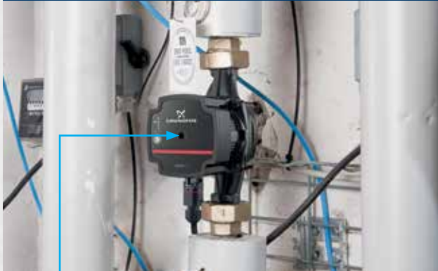
Siurblio veleno ir darbinio rato atblokavimui rankiniu būdu (atsuktuvu) skirta anga
